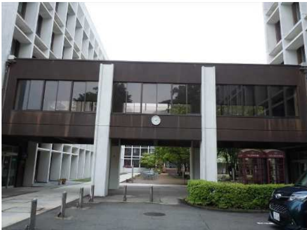
E 3号館とE 2号館の渡り廊下
