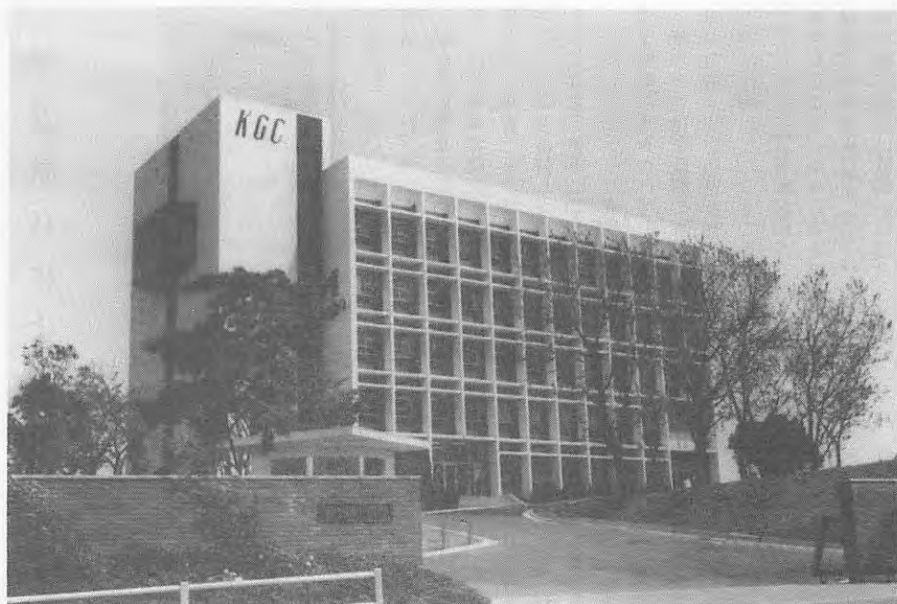
正門より2号館をのぞむ
